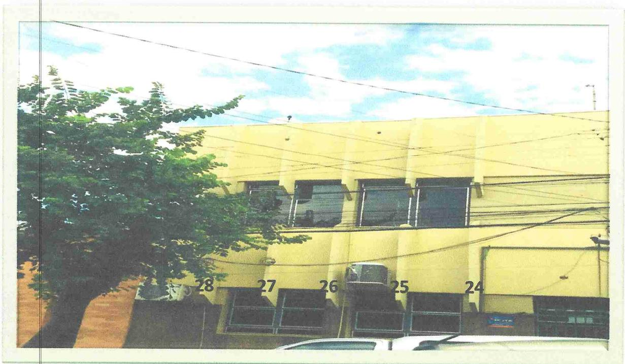
**Vinte e quatro:** Brise inferior parte inferior do brise descolamento do revestimento, pontos de ferrugem. O brise superior deverá ser retirado o revestimento nas cinco faces; Raspagem e pintura.
