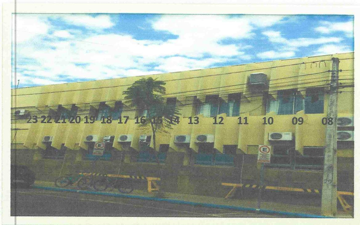
**Oito:** O brise inferior deverá ser retirado o revestimento nas cinco faces. Brise superior, raspagem e pintura;
